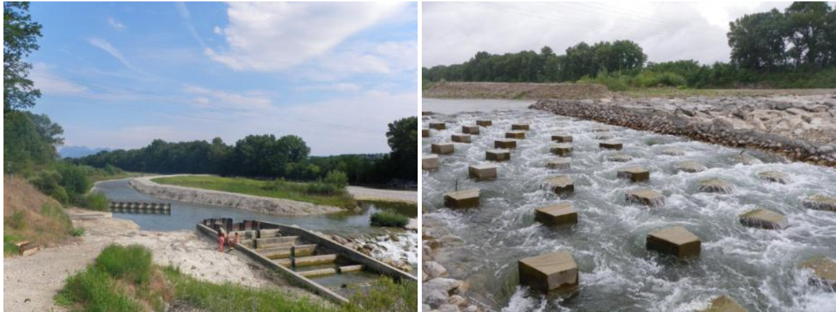
Le Seuil des Pues en juillet 2010 (à gauche) et en juin 2011 (à droite) équipé d'une passe permettant la circulation des apons
